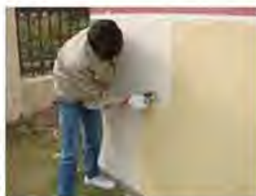
无机饰面砂浆刮抹
