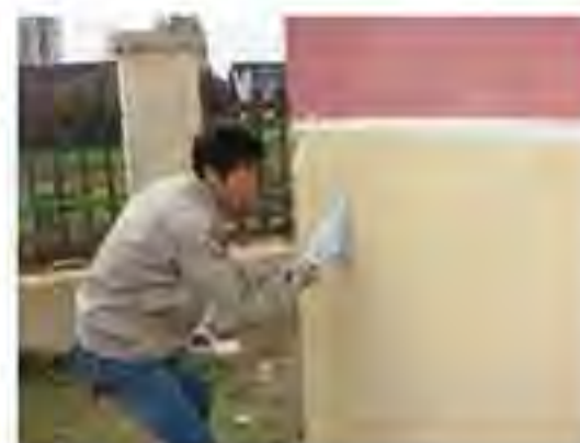
无机饰面砂浆打磨
