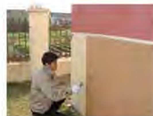
无机粉末涂料施工
