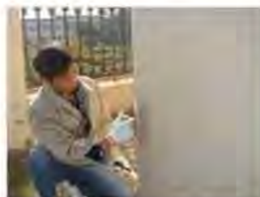
无机抗渗界面剂施工
