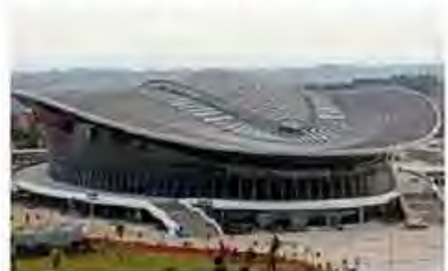
广西体育中心项目
